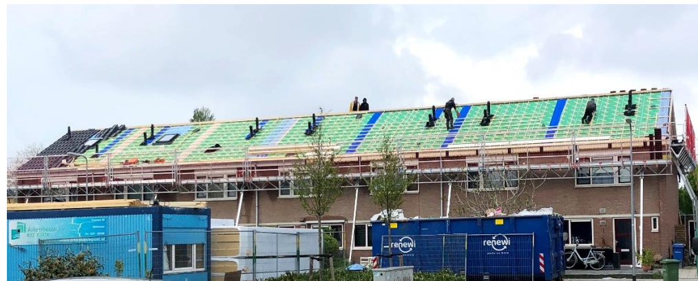
Foto boven: dakvervanging in uitvoering
